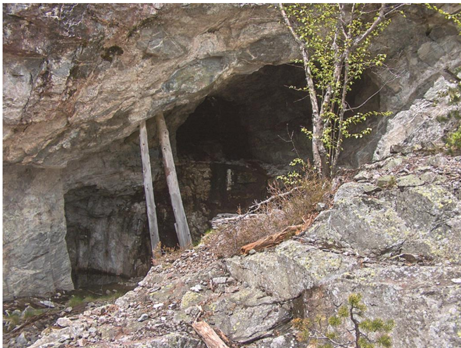
Fig. 3. Dagstrossen mot stollåpningen og synken ned til venstre. Foto: R. Tveito.
