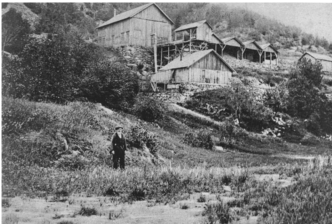
Bleka gruver. Åpne malmbinger til høyre, oppberedningsverket til venstre for disse og smelteovnen i framkant. Antagelig 1930-tallet. Foto: Seljord Sogelags fotosamling.
