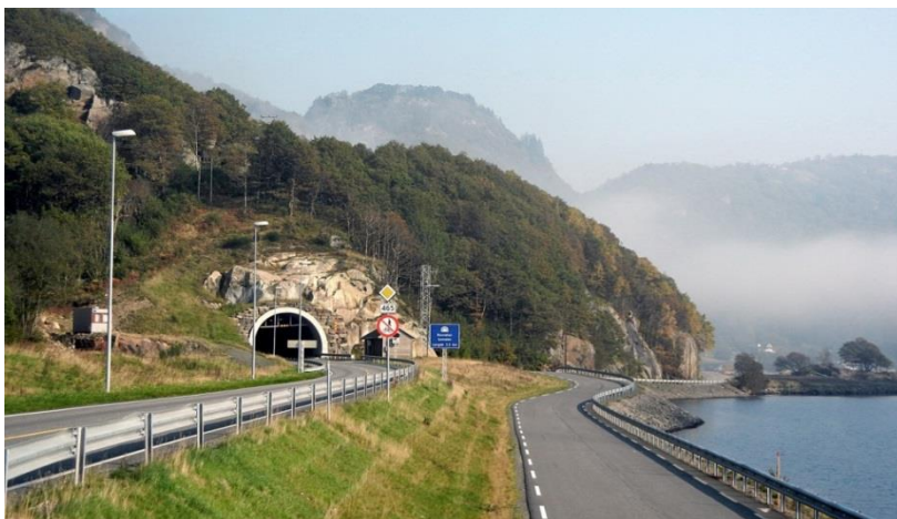
Fig. 1. Ravneheitunnelen, søndre innløp. Foto: AOL.
