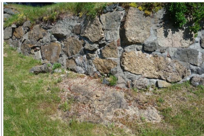
Figur 13. Del av festningsmuren (til venstre for festningsporten) med innmurte blokker av pegmatitt. Fjellet som blottes under muren er også en syenittpegmatitt. Foto juni 2021.
