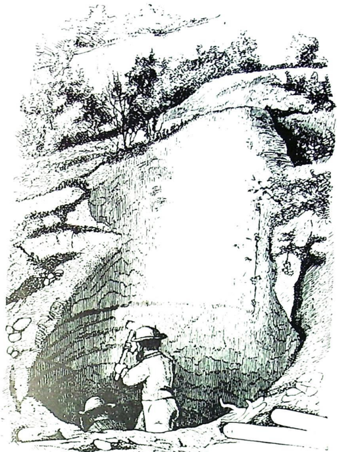
Utgravingen av jettegryten på Bekkelaget 1873. Illustrasjon i Brøgger og Reusch's avhandling, etter tegning av H.H. Reusch. Jettegryten ser fremdeles slik ut.
