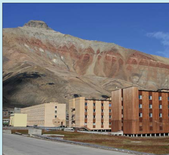
De solide boligblokkene i Pyramiden står fint ennå, men uten vedlikehold vil forfallet komme raskt i dette tøffe klimaet.
