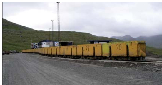
Vognsett for utkjøring av pukk.
