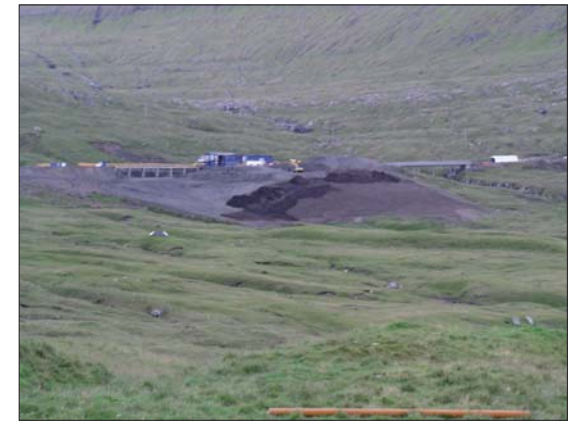
Anleggsriggen med fasiliteter og berghald. Sistnevnte jordekkes.
