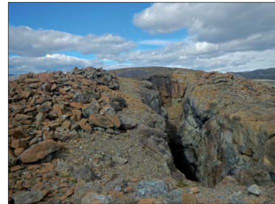
Loddrette sjakter uten sikring ved Verket kromittgruve.
