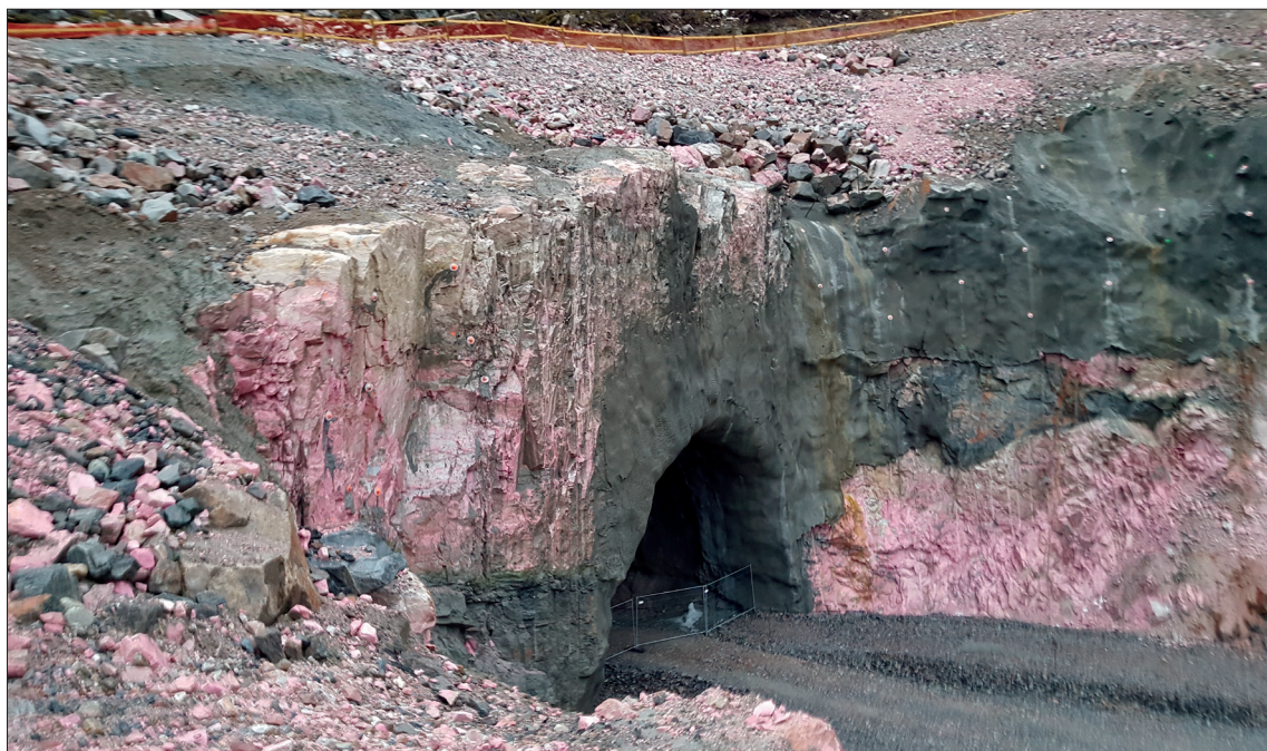
Fig. 1: Søndre tunnelpåslag, med dels blottet thulitt i stor mektighet, samt sprøytebetong i tunnelen og rundt inngangen.
