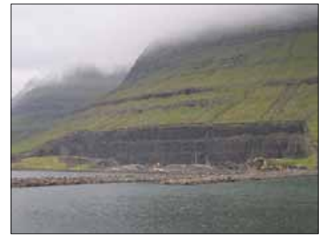
Fig. 5. Stenbrottet i Strond på Borðoy.
