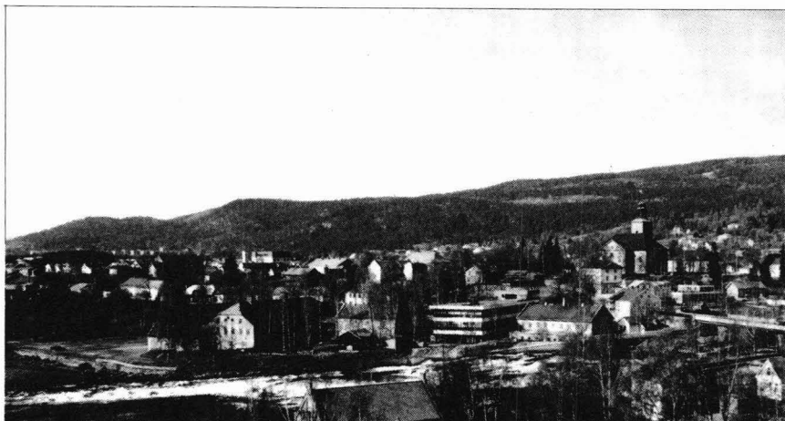
Nybrua er helt til høyre. De tre bygningene ved elva like nedenfor brua er "Den Konglige Mynt". Resten av bygningene langs elva ned mot parkområdet er de gamle sølvverksbygningene, nå "Bergverksmuseet".
