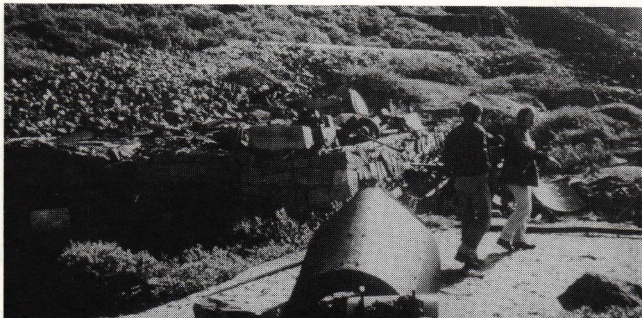
Restene av Elmore oppredningsverk med tipphaugene utenfor. Stollene i bakgrunnen. Foto: J.P. Rønningen.
