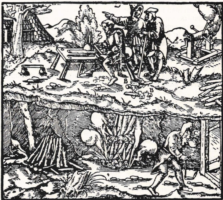
Fyrsetting på 1500-tallet, slik Agricola gjenga den i De re metallica .
