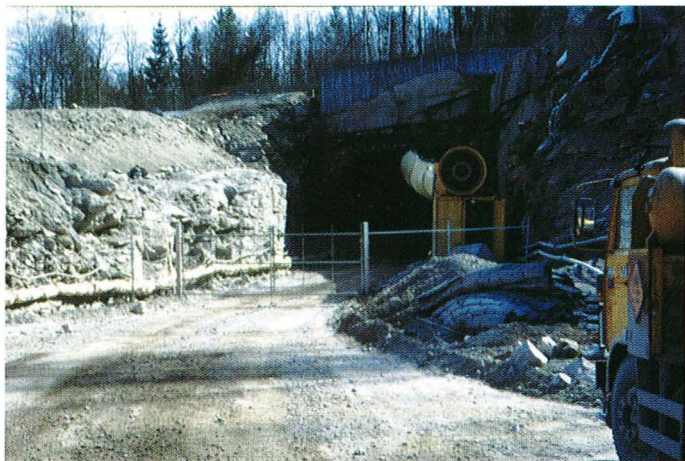
Åpningen til Strømsøtunnelen, E134, ved Bjørkelia/Gulskogen, mars 1997. Foto Ørnulf Nordli.
