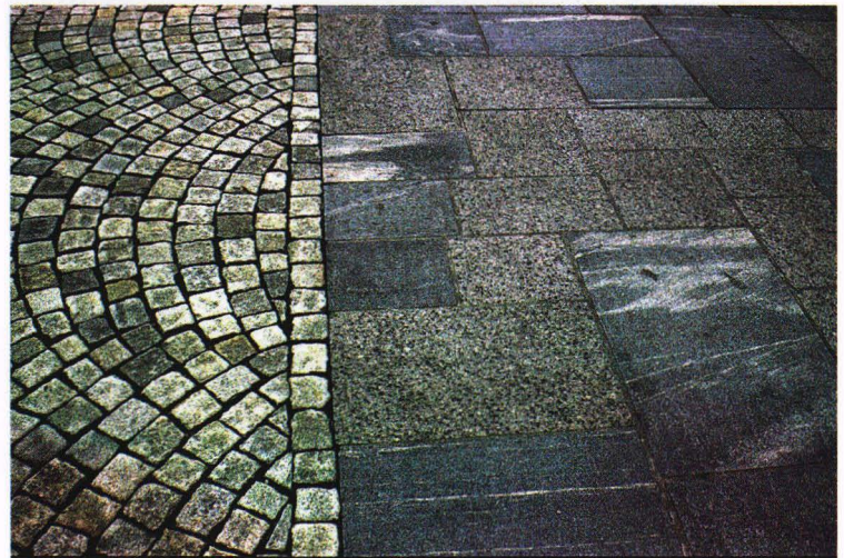
Ole Bulls plass. Bergens nye steingulv med gneis fra Askøy, granitt fra Eidfjord og gammel gate "gjenbrukt" og lagt i tradisjonelt buemønster.
