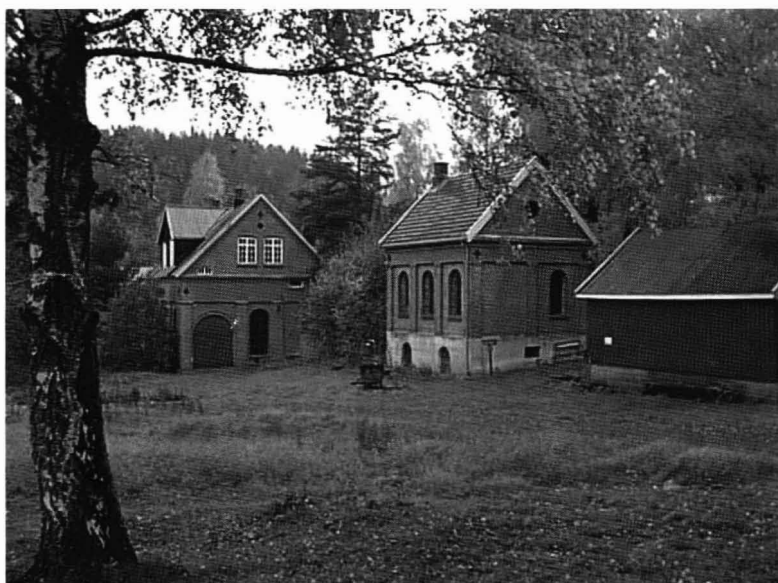
Det påtenkte messeområdet, sett fra Verkshallen i retning mot Eidsfoss sentrum. I midten dampbadet, til høyre kraftstasjonen.
