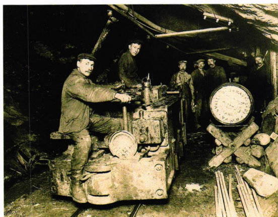
Elektrisk lokomotiv til transport av malm fra 1908. Foto N. Helgesen/Sulitjelma gruvemuseum.
