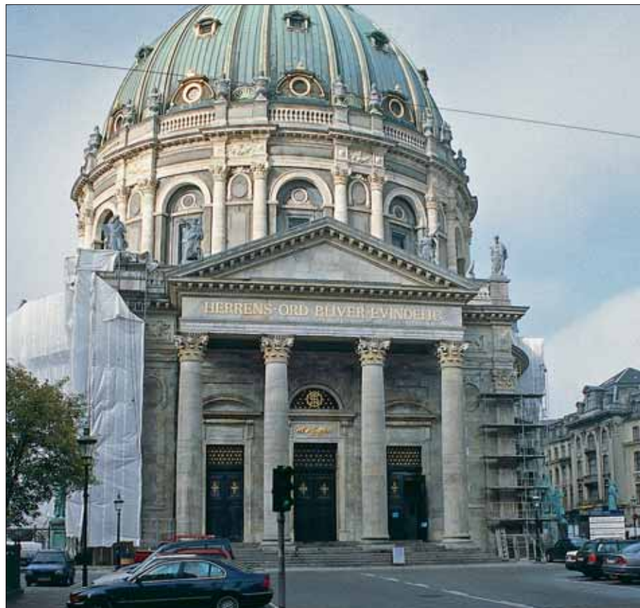
Marmorkirken i København. Gjellebekkmarmor er vakker, men litt løs og kornet. Røyk, sot og sur nedbør tæret hardt på den porøse steinen, og slik at veggene etter hvert ble svarte. I de senere år har det foregått en storstilt restaurering, og Marmorkirken fremstår i dag som en av Københavns vakre severdigheter.
