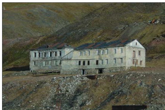
Bare noen få bygninger står igjen etter gruvedriften i Grumant. På det meste (1950) bodde nærmere 1000 mennesker her, inneklemt mellom de bratte fjellene og Isfjorden.
