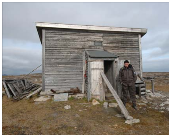
Zachariassens hus fra 1900 på Bohemanneset er den eldste bygningen som fremdeles står fra Svalbards tidligste kullgruvedrift.
