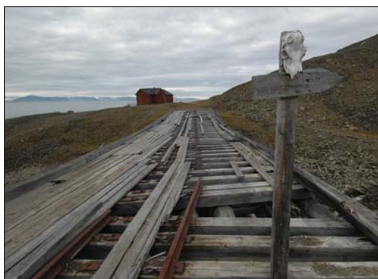
Jernbanetraseen mellom Grumant og Colesbukta med Rusanovhuset i bakgrunnen.
