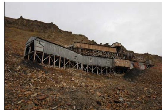
Daganlegget til Nye Gruve 2 er bevart ganske intakt, men taubanen blåste ned i en orkan.
