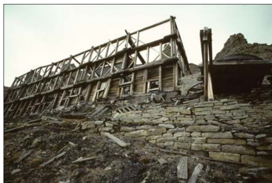
I dag sees restene av lasteanlegget for taubanen ved gruveåpningen til Gruve 1 oppe i fjellsiden ovenfor kirken i Longyearbyen.
