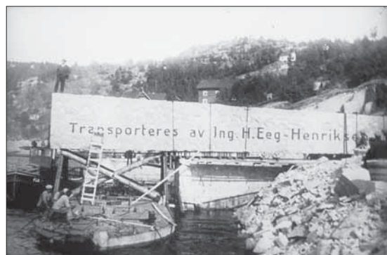
Steinblokka lastes over på lektere. Foto: H. Eeg-Henriksen. Utlånt fra Halden Historiske samlinger.
