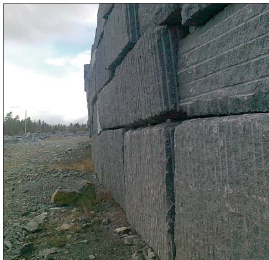
Den vanlige veien opp til Tuften langs "muren" av vrakblokker.
