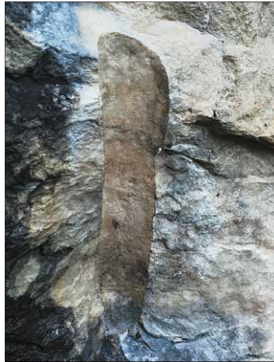
Tydelig merke etter borehull i marmorberget. Foto Ingvar Dahlen.
